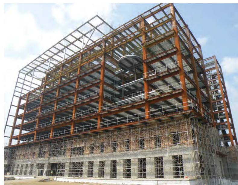
上圖為地上樓層鋼柱及鋼樑吊裝完成。 左圖為基礎結構鋼筋施工。
