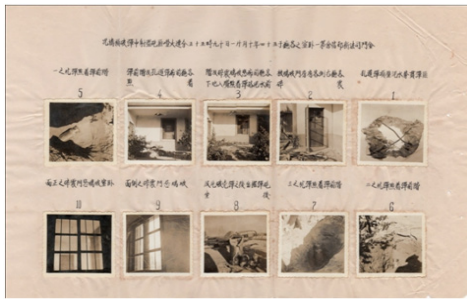
照片 2：民國 54 年 10 月 21 日金門監獄司法新邨宿舍第 1 臥室客廳遭大嶼匪炮射中後設施毀損情形。
