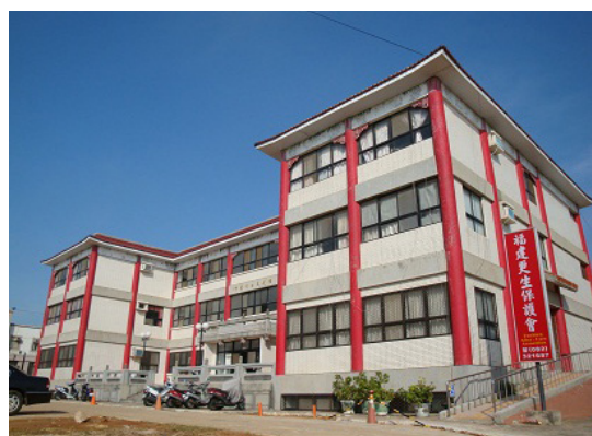
更生保護大樓外牆整修美化（完工後）
