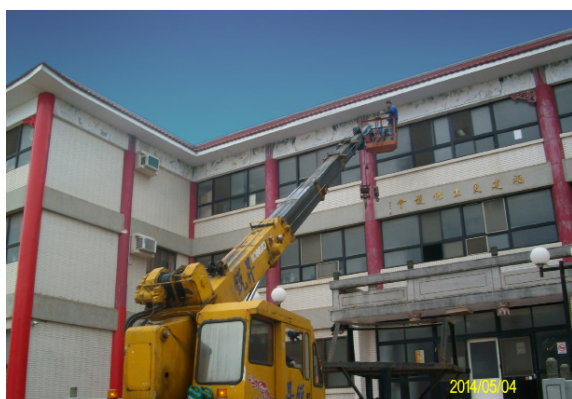
更生保護大樓外牆整修美化（施工中）
