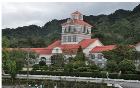
照片 1：自強外役監獄紅瓦白牆建築現況
