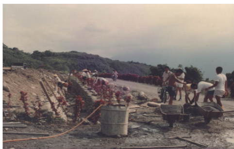
照片 5：收容人努力揮汗建設
