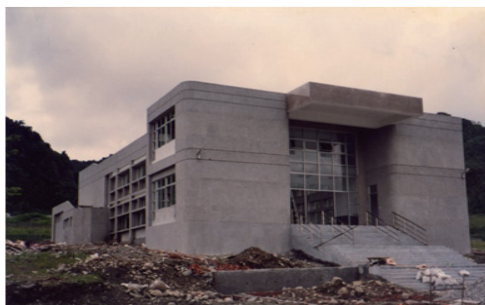
照片 3：教誨堂興建工程
